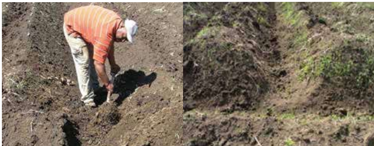
Figura 18. Labor de desboquillado (izq.), Muros desboquillados (der.)
