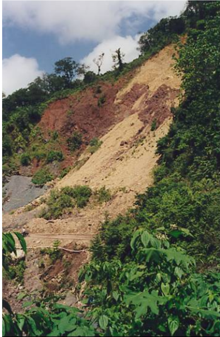
Deslizamientos de tierras en Las Filipinas, Barahona.
