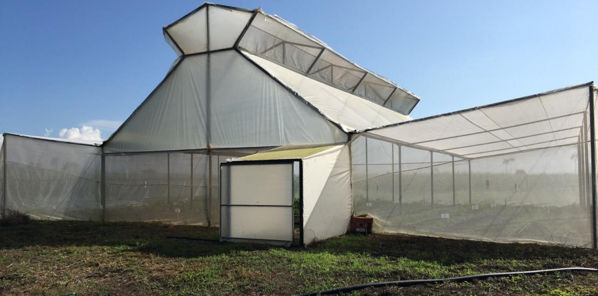
Figura 2. Estructura híbrida (laterales casa malla, centro invernadero) a escala real establecida en la Estación Experimental Sabaneta, IDIAF, Centro Norte, La Vega, República Dominicana. Fuente: propia, 2021.
